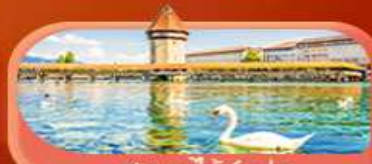
สะพานไม้ซังปก
